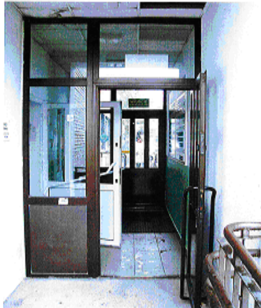
Drzwi wejściowe w Powiatowym Urzędzie Pracy w Sieradzu
