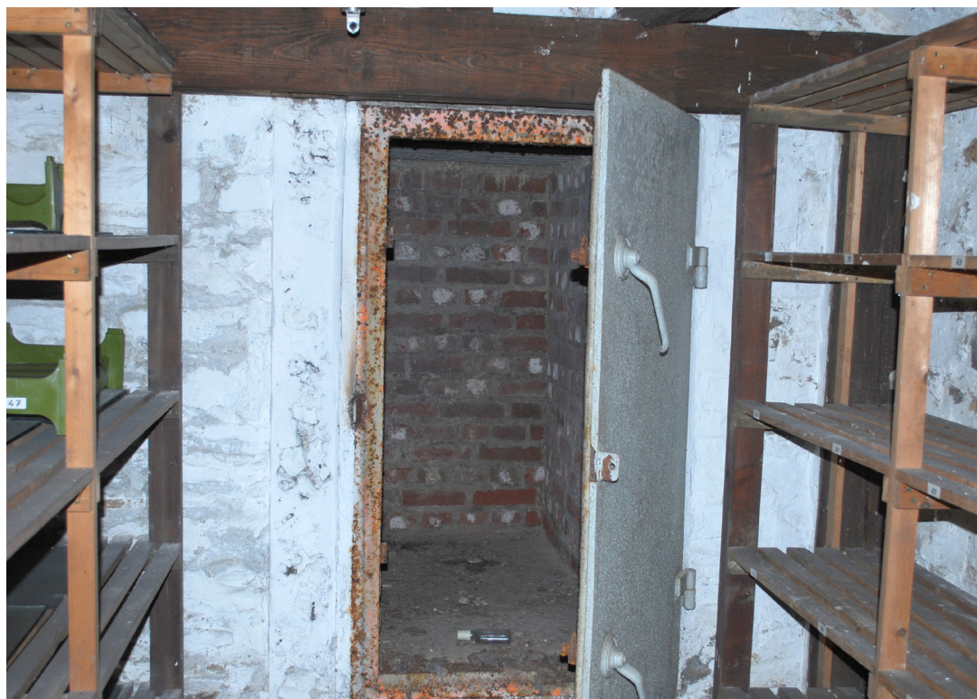
Zdjęcie nr 15 Piwnica
