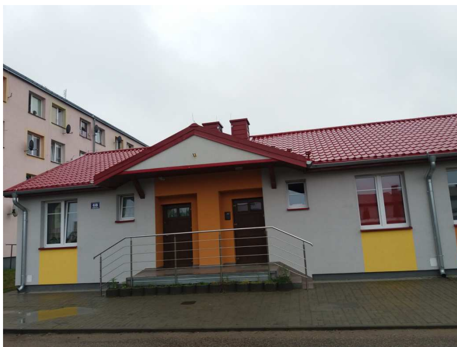
Zdjęcie nr 5 - Nidzica, budynek komunalny
