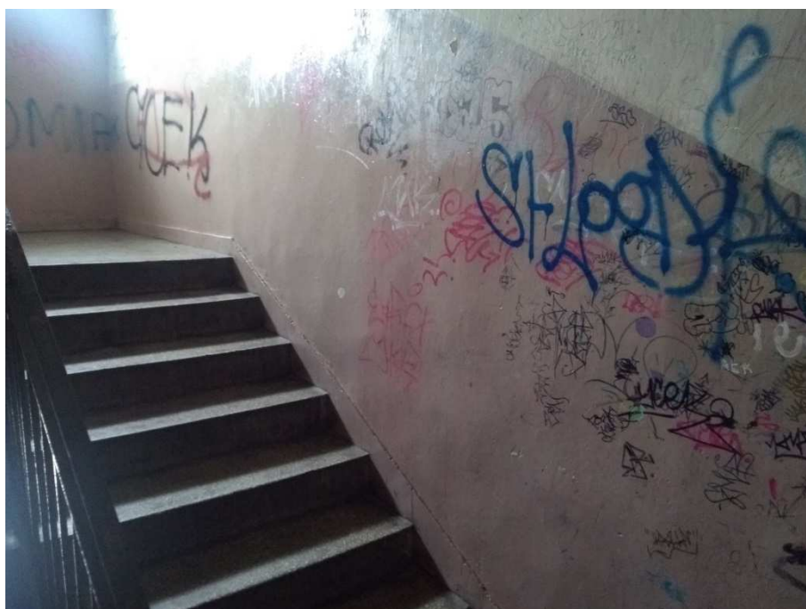
Zdjęcie nr 7 – budynek socjalny w mieście Radom
