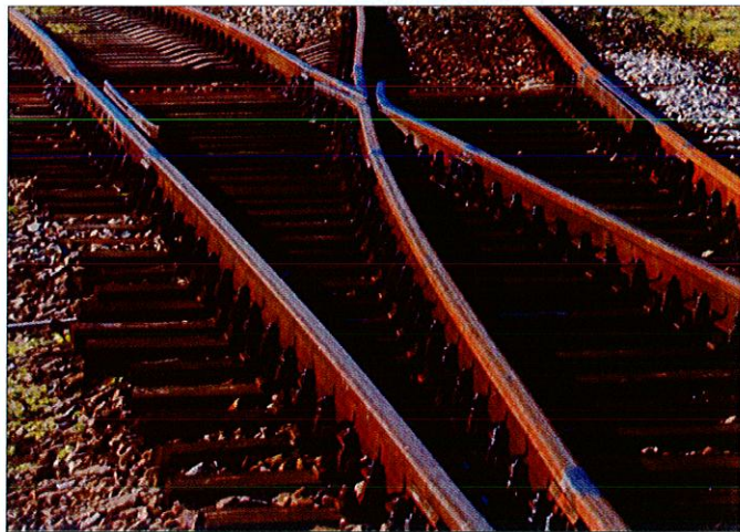
(Zdjęcie pozyskano w ramach kontroli NIK)
