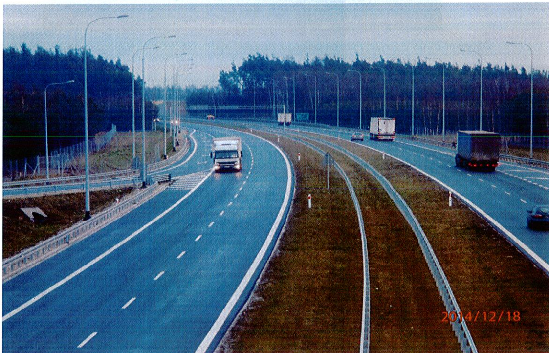
Zdjęcie nr 4 fragment drogi ekspresowej S-8. Źródło: kontrola NIK
