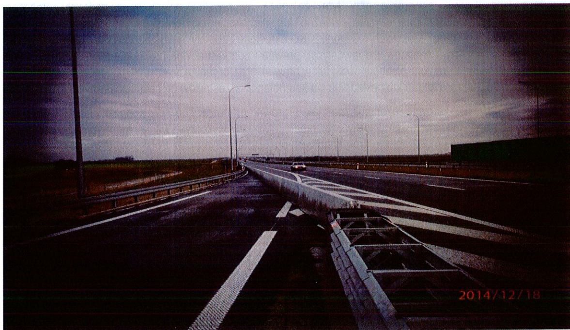
Zdjęcie nr 1. Fragment drogi ekspresowej S-8.
