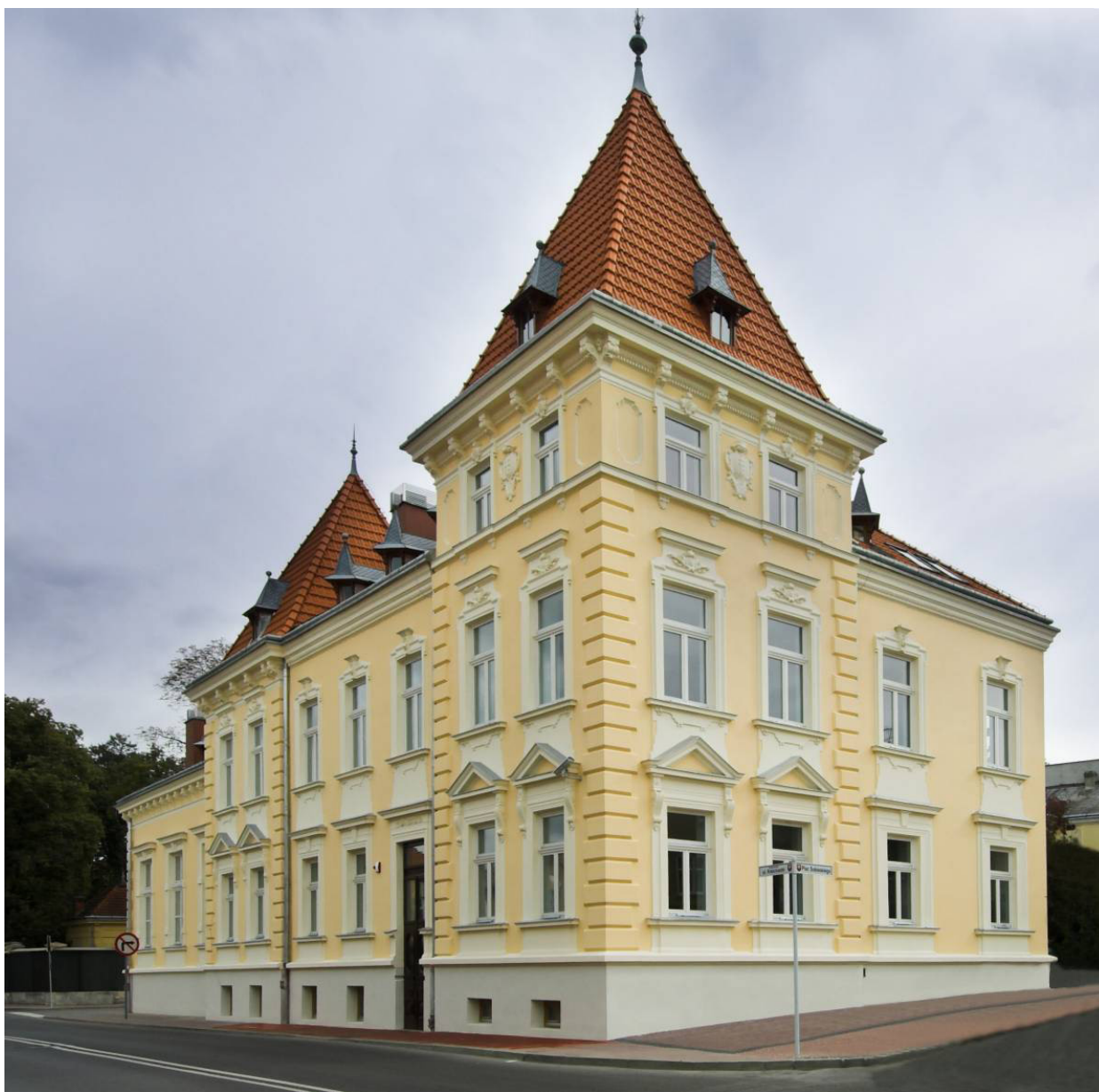
Zdjęcie nr 24 Budynek Kasyna Urzędniczego
