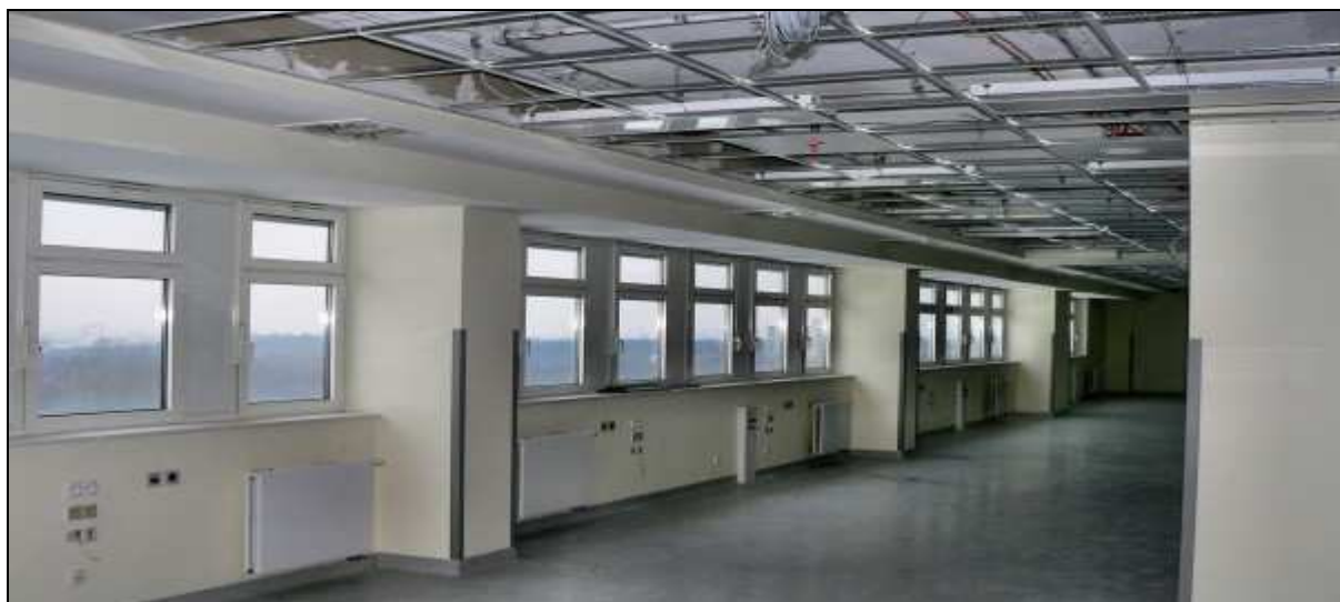
Rys. 3. Centrum Kliniczno-Dydaktyczne Uniwersytetu Medycznego w Łodzi - w budowie (roboty wykończeniowe).
