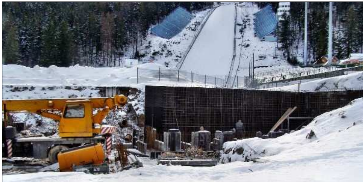
Rys. 31. Widok placu budowy.
