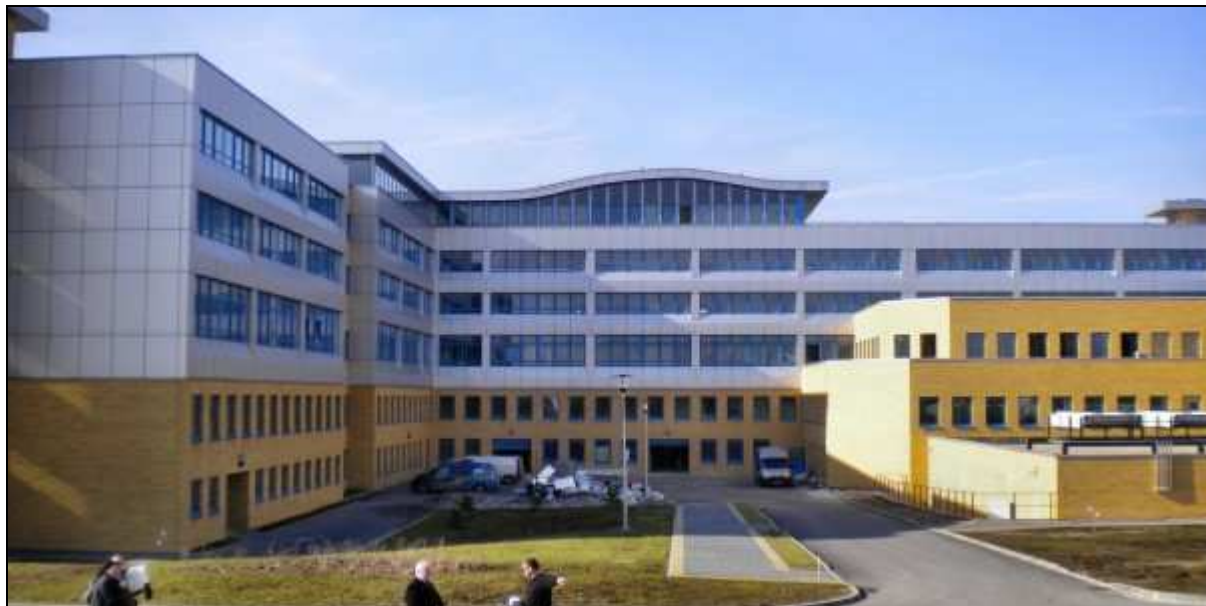
Rys. 29. Kompleks budynków Szpitala
