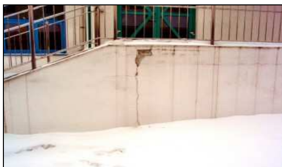
Rys. 16. Uszkodzenia niezabezpieczonych elementów budynków Centrum Kliniczne Akademii Medycznej we Wrocławiu
