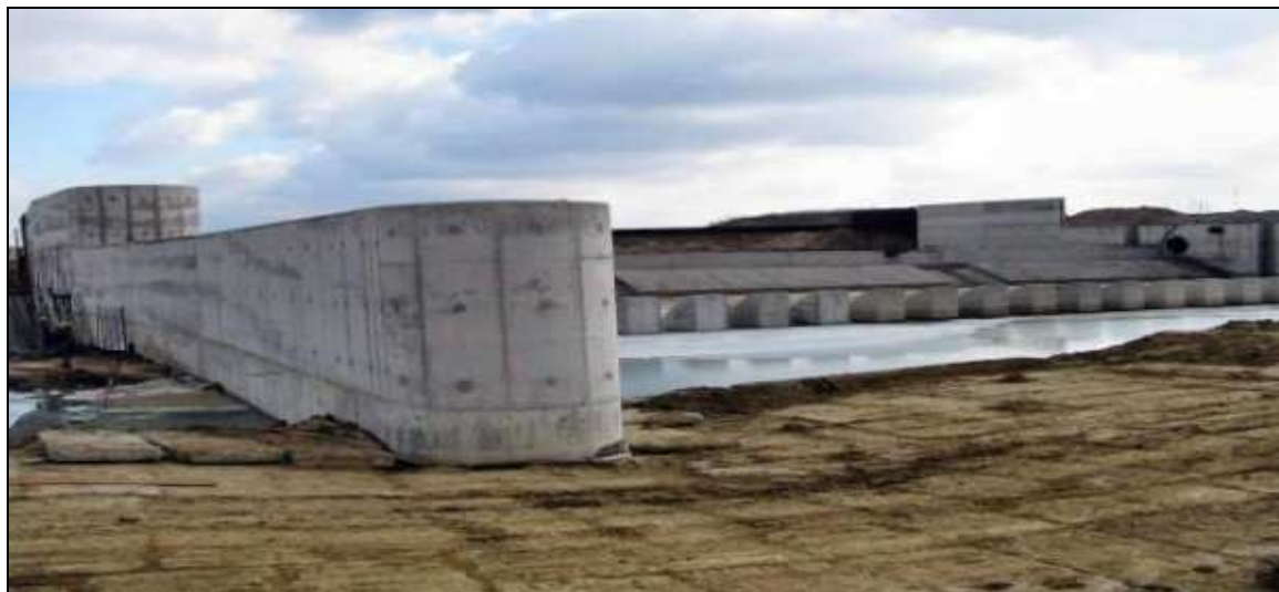
Rys. 19. Stopień wodny Malczyce na rzece Odrze – w budowie.
