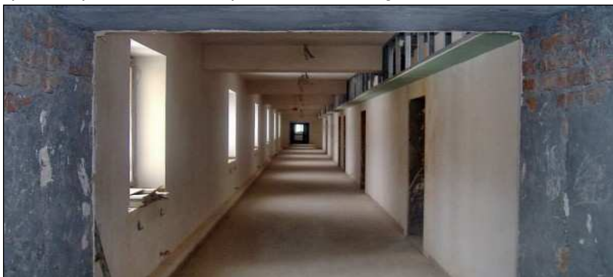
Rys. 15. Roboty budowlane wewnątrz budynku Archiwum Państwowego w Kielcach.
