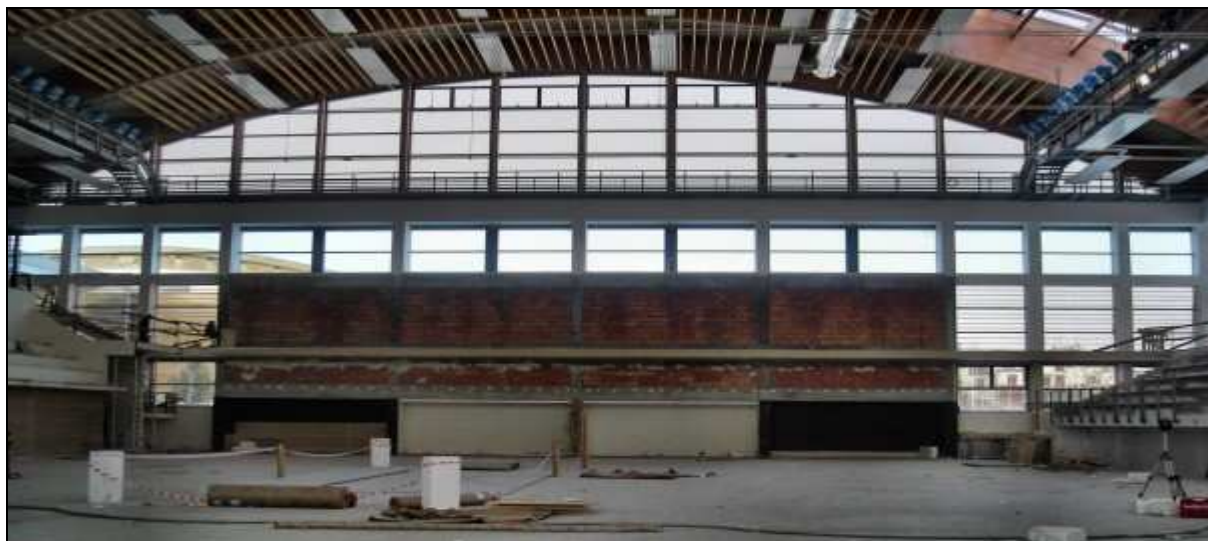
Rys. 6. Budowa Hali Sportowej Poznań-Morasko dla Uniwersytetu im. Adama Mickiewicza w Poznaniu.
