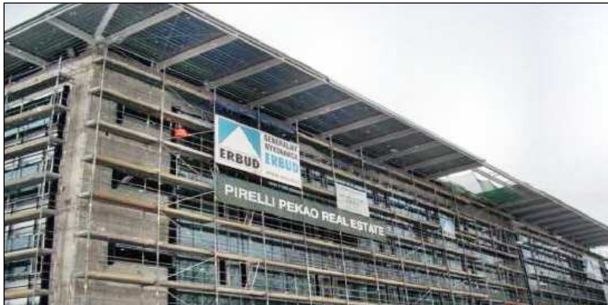
Rys. 26. Roboty elewacyjne budynku Centrum.
