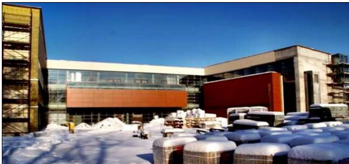
Rys. 20. Budynek dydaktyczny Uniwersytetu im. Adama Mickiewicza w Pile - w budowie.
