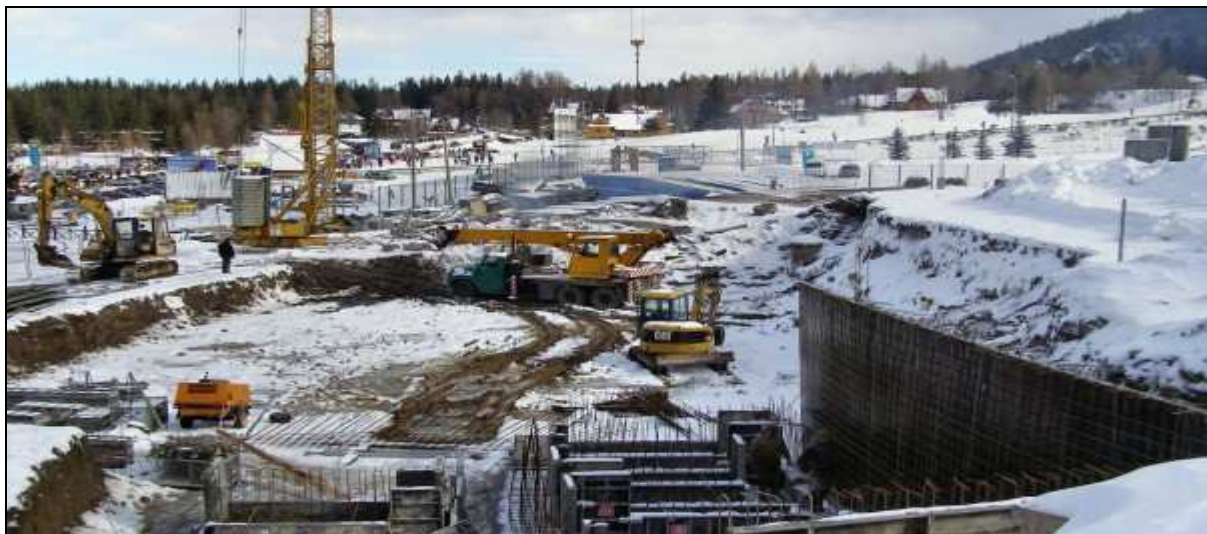
Rys. 12. Plac budowy inwestycji pn. "Przebudowa pawilonu sportowego przy Wielkiej Krokwi w Zakopanem".
