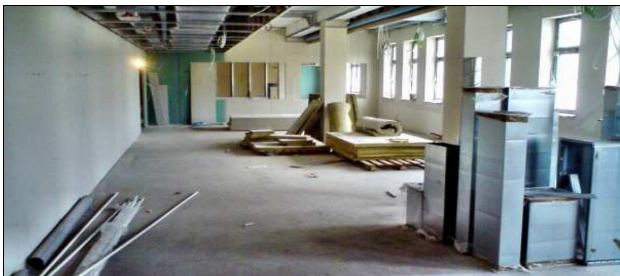
Rys. 8. Roboty budowlane wewnątrz nowego skrzydła budynku Instytutu Gruźlicy i Chorób Płuc w Warszawie
