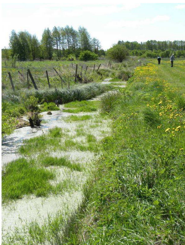
Fotografie nr, nr 25, 26, 27 i 28. Wypłycony i zarośnięty rów główny H na obiekcie Głęboczyzna-Podostrówek z 1984 r. (obwód Gryniaczki), gmina Suchowola, powiat sokólski, na terenie działania GSW „Brzozówka” w Suchowoli
