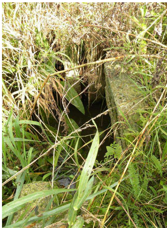
Fotografie nr, nr 21 i 22. Uszkodzona przepusto-zastawka w rowie na obiekcie Suraż I z 1972 r. (obręb Suraż), gmina Suraż, powiat białostocki
