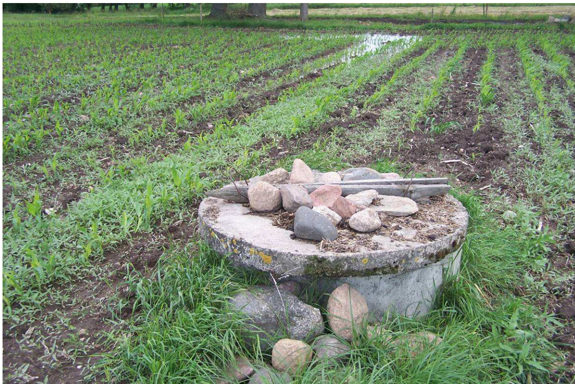
Fotografia nr 40. Studzienka drenarska pełna wody i podtopiony fragment gruntów rolnych na obiekcie Grodzisk Makarki (obwód Rybały), gmina Grodzisk, powiat siemiatycki, na terenie działania GSW w Grodzisku
