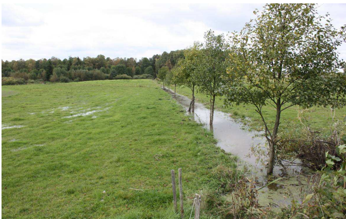
Fotografia nr 39. Fragment rowu A-4 ze spiętrzoną wodą i zalaną łąką na pow. ok. 3 a. na obiekcie Łumbie-Klejwy (obręb Gryszkańce), gmina Sejny, powiat sejneński, na terenie działania GSW „Marycha” w Sejnach
