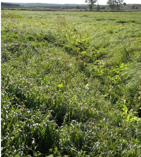
Fotografie nr, nr 29 i 30. Wypłycony fragment rowu głównego RC i rowu bocznego (R-C8) na obiekcie Studzianki z 1968 r. (obwód Studzianki), gmina Wasilków, powiat białostocki, na terenie działania GSW „Supraślanka” w Wasilkowie
