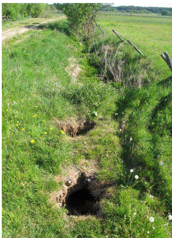
Fotografie nr, nr 19 i 20. Zniszczona zastawka oraz przepust na obiekcie Nurczyk z lat 1970 i 1983-1989 (obręb Milejczyce), gmina Milejczyce, powiat siemiatycki
