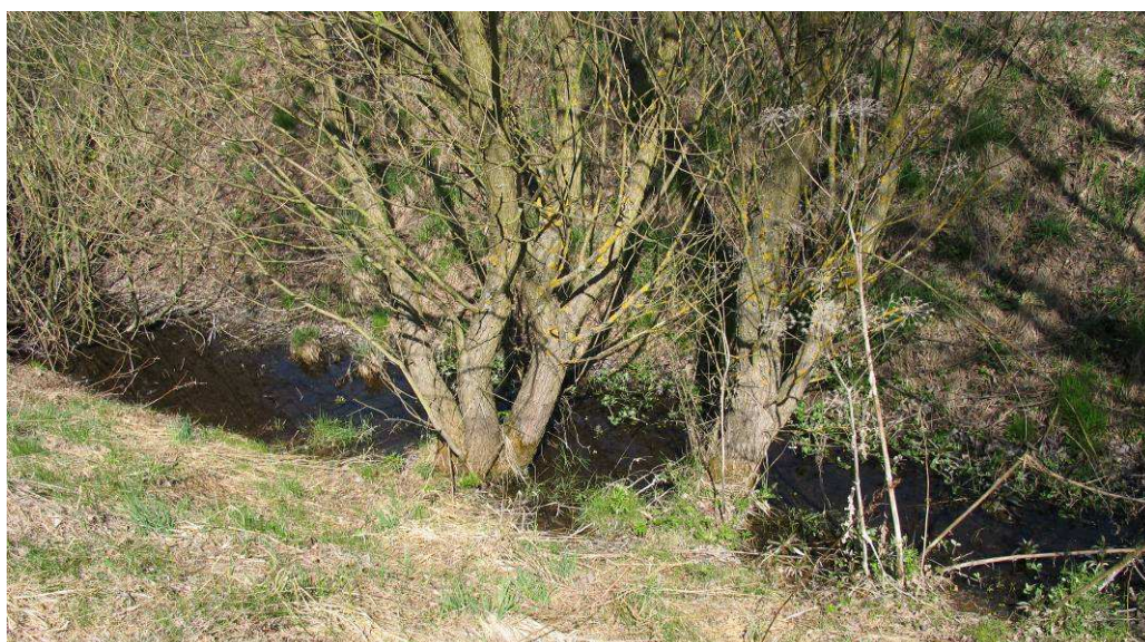
Fotografie nr, nr 7, 8 i 9. Drzewa i krzewy w rowach melioracyjnych na obiekcie Kumiałka-Kupiski z 1990 r. w obrębie Wasilówka, gmina Janów, powiat sokólski
