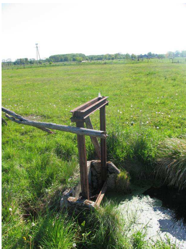
Fotografie nr, nr 19 i 20. Zniszczona zastawka oraz przepust na obiekcie Nurczyk z lat 1970 i 1983-1989 (obręb Milejczyce), gmina Milejczyce, powiat siemiatycki
