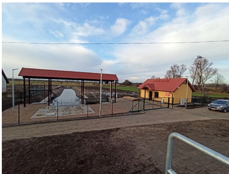
Zdjęcie nr 9 Stacja pomp nr 7 Koszwały
