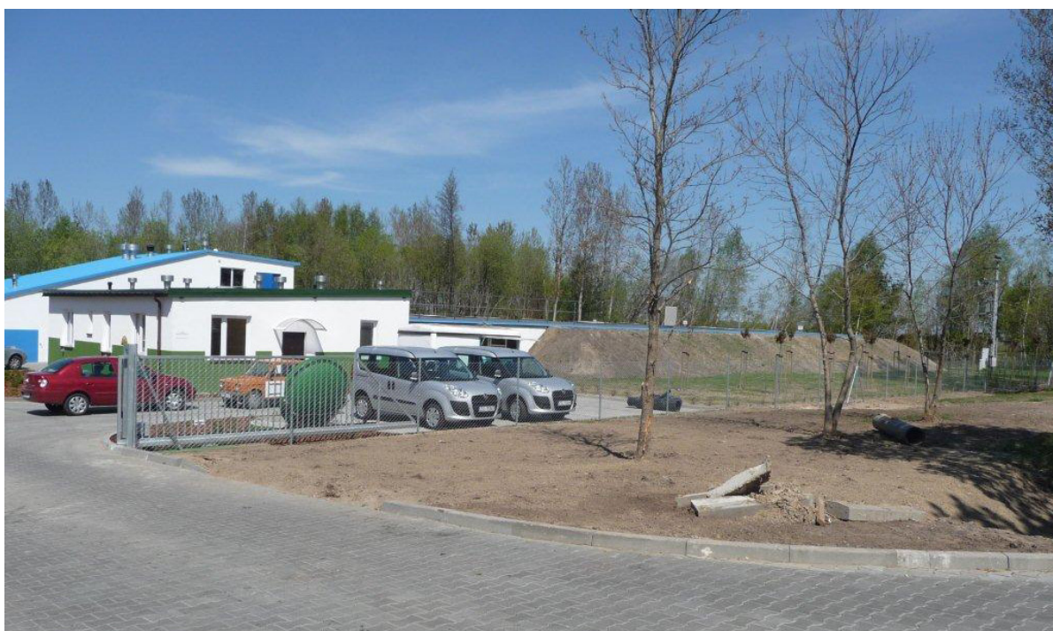
Zdjęcie nr 4 – Widok ogólny oczyszczalni ścieków
