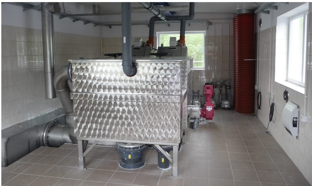
Zdjęcie nr 6 – Budynek krat
