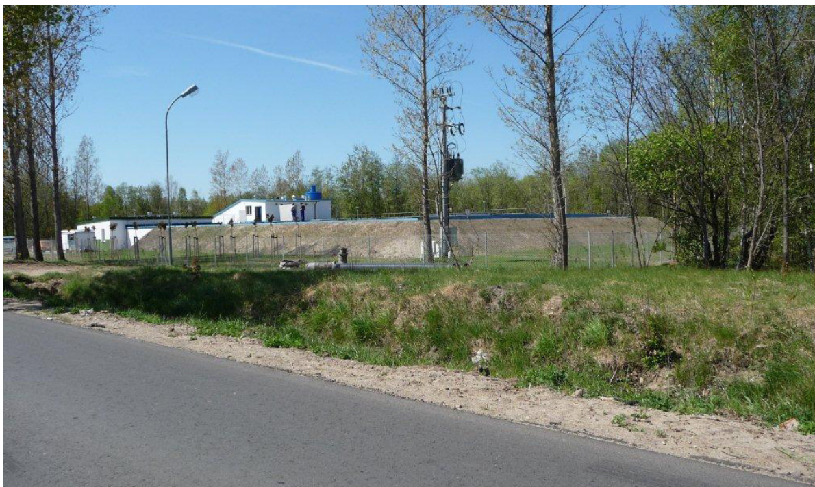
Zdjęcie nr 7 – Widok ogólny oczyszczalni ścieków w m. Rusko
