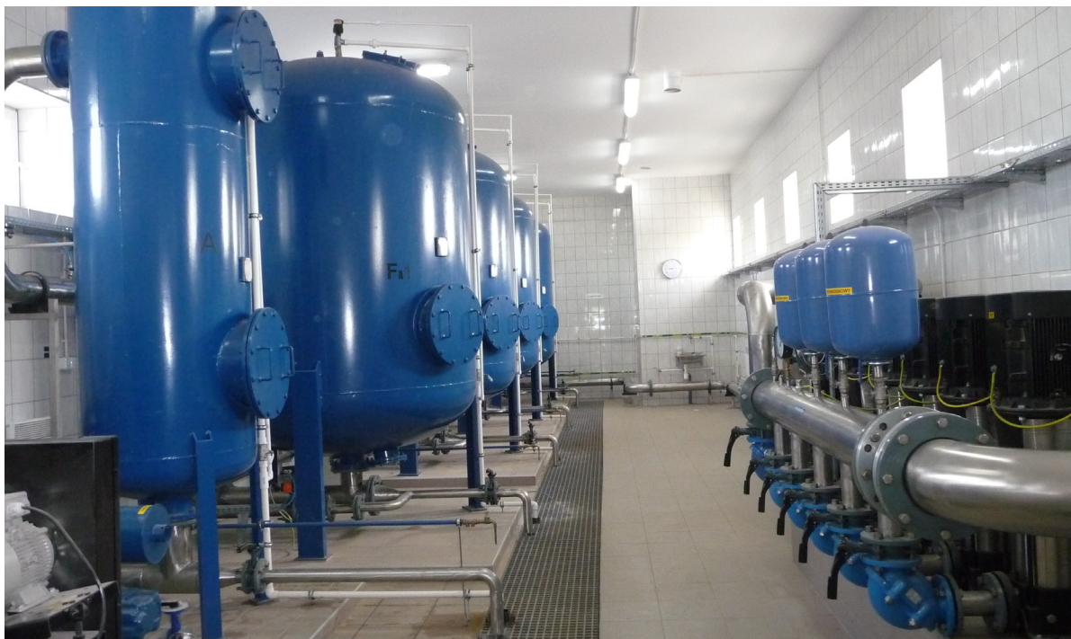
Zdjęcie nr 11 – Wnętrze SUW (odżelaziacze i odmanganiacze)
