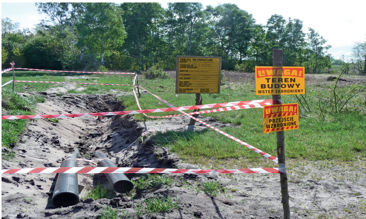
Zdjęcie nr 12 – Budowa sieci kanalizacyjnej w Gminie Darłowo (z m. Dąbki do m. Rusko)
