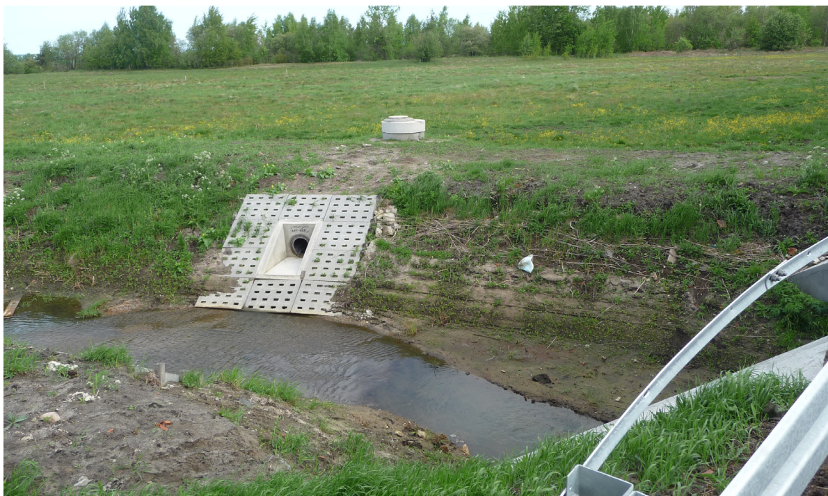
Zdjęcie nr 8 – Wylot ścieków oczyszczonych (oczyszczalni ścieków w m. Rusko)
