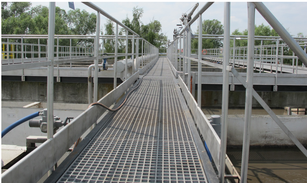
Zdjęcie nr 15 – Reaktor biologiczny BIO – przebudowa
