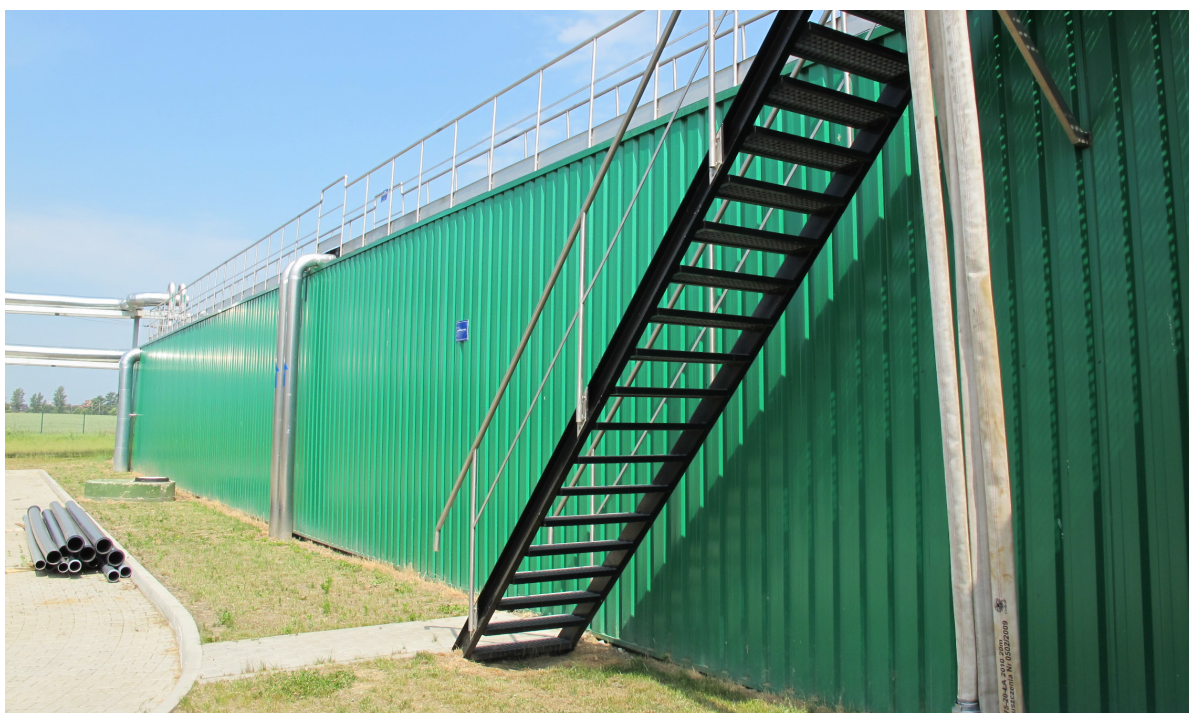
Zdjęcie nr 14 – Reaktor biologiczny BIO (komora nityfikacji, osadnik wtórny radialny, komora fakultatywnej nityfikacji/denityfikacji, zbiornik magazynowy osadu ustabilizowanego)
