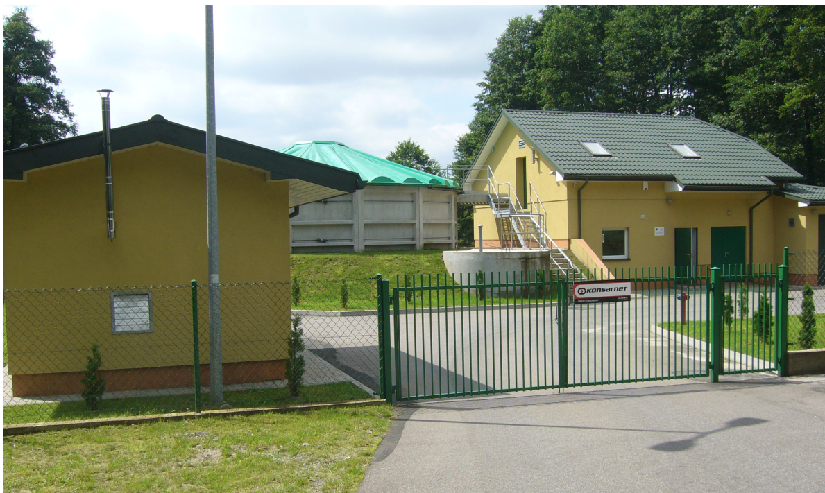
Zdjęcie nr 13 – Widok ogólny oczyszczalni ścieków w m. Dmosin Drugi
