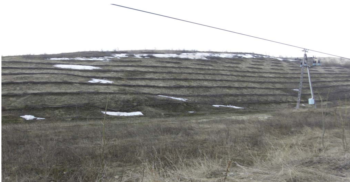
Fot. 1. Umocnione faszyną i obsadzone sadzonkami drzew iglastych zwały poeksploatacyjne w Grzybinach w woj. warmińsko mazurskim po byłym zakładzie górniczym, należącym do Olsztyńskich Kopalni Surowców Mineralnych
