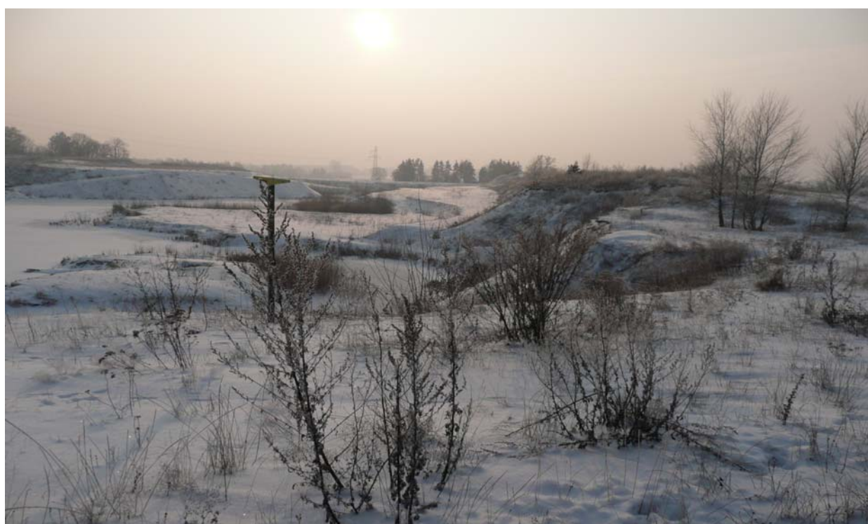
Fot. 3. Widok ogólny wyrobiska w obrębie Gnojewo, po przeprowadzeniu nieuznanej przez Starostę Działdowskiego rekultywacji (głównie ze względu na zbyt duży skłon skarp przy braku skutecznych ich umocnień)
