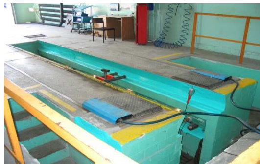
Stacja kontroli pojazdów w Zaczerniu (KWP w Rzeszowie)
