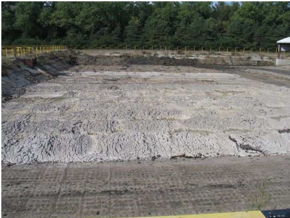
Fotografia nr 8. Kondycjonowanie osadów na poletkach oczyszczalni.
