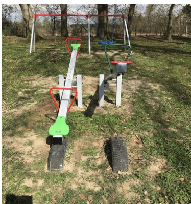
Huśtawki wagowe zamontowane bez wymaganej wielkości strefy bezpieczeństwa pomiędzy urządzeniami
