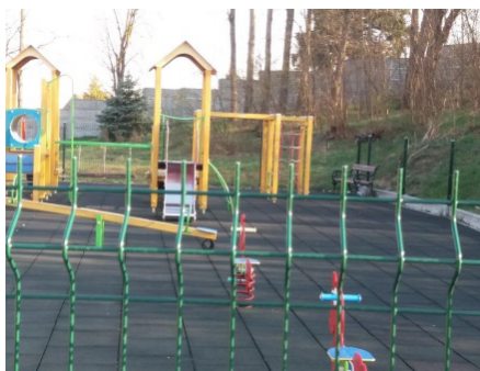
Ostre zakończenia paneli ogrodzenia
