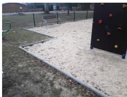
Wystające ponad powierzchnię krawężniki
