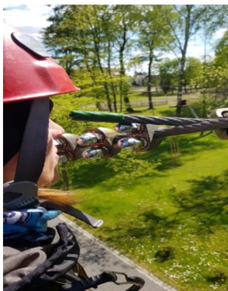
Wystająca końcówka liny na trasie
