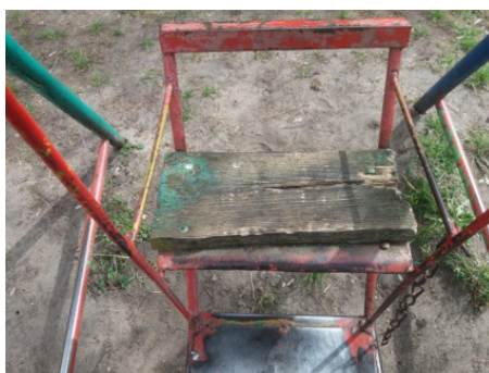
Huśtawka z uszkodzonym siedziskiem
