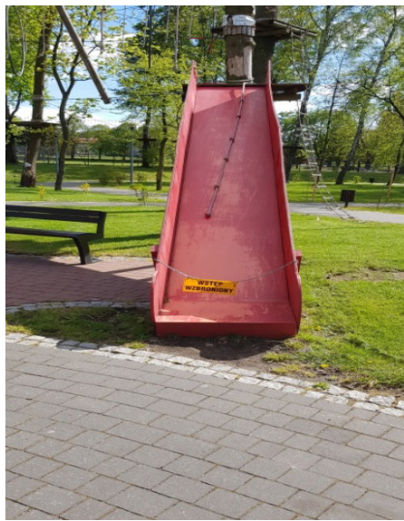
Kamienna i betonowa nawierzchnia przy zakończeniu ślizgu zjeżdżalni
