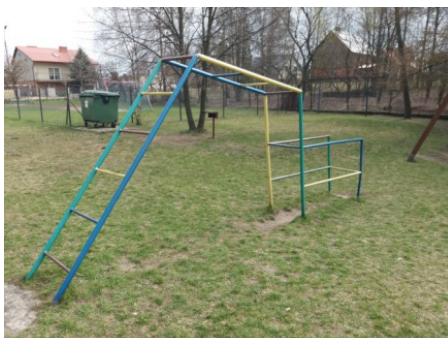
Brak nawierzchni amortyzującej upadki pod wysoką drabiną
