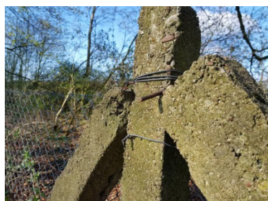
Ogrodzenie z wystającym prętem
