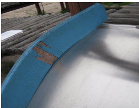
Uszkodzony ślizg zjeżdżalni
