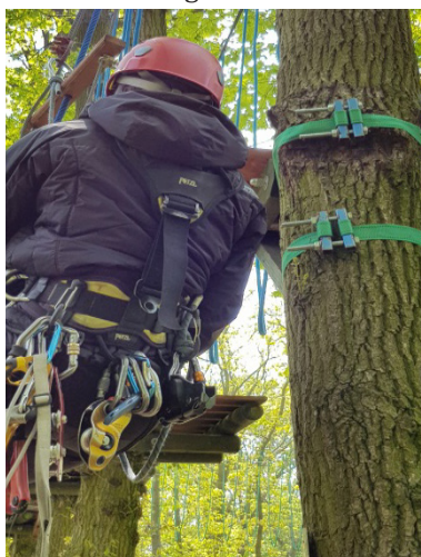
Niezabezpieczone końcówki śrub
