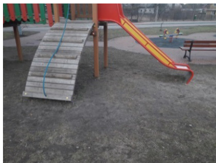
Urządzenia, przy których nie wykonano nawierzchni amortyzującej upadki
