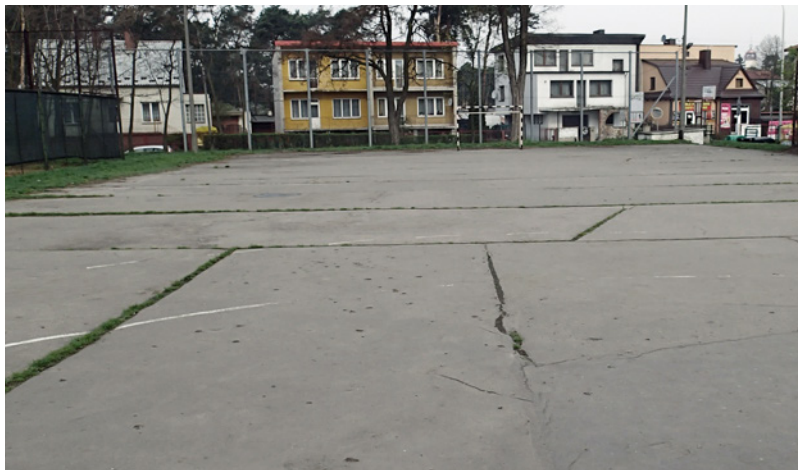
Teren szkoły przed remontem
