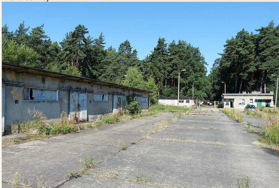
Fotografia nr 1. Nieruchomość w Głewicach (zasób Oddziału Regionalnego w Szczecinie).
