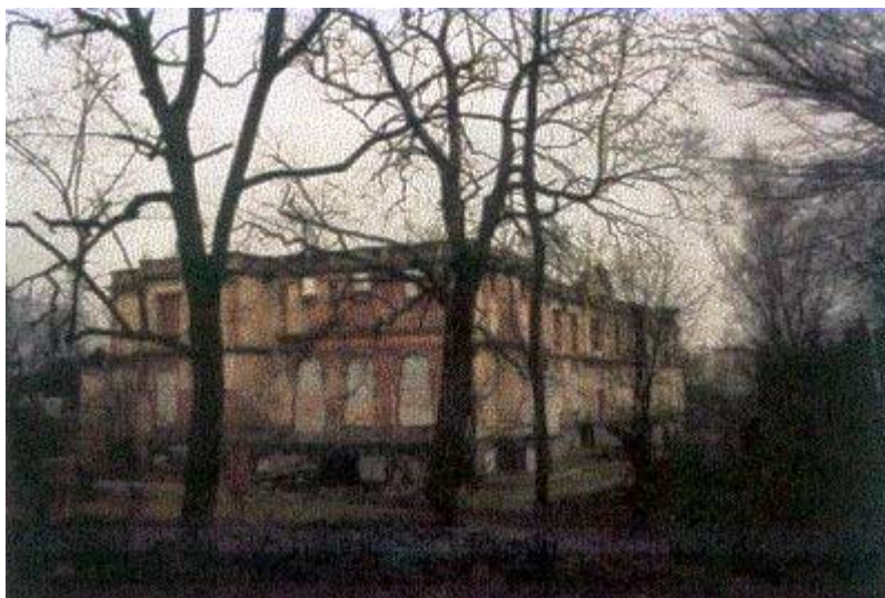
Ruina Pałacu w Witnicy - widok od strony parku (strona południowo-wschodnia)
