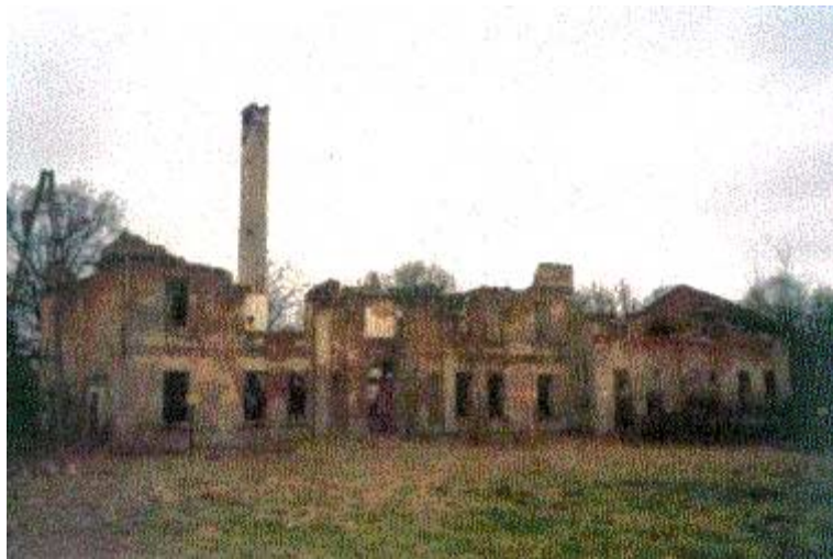
Ruina pałacu w Kąkolewiczach – widok od strony podwórza (północna elewacja)
