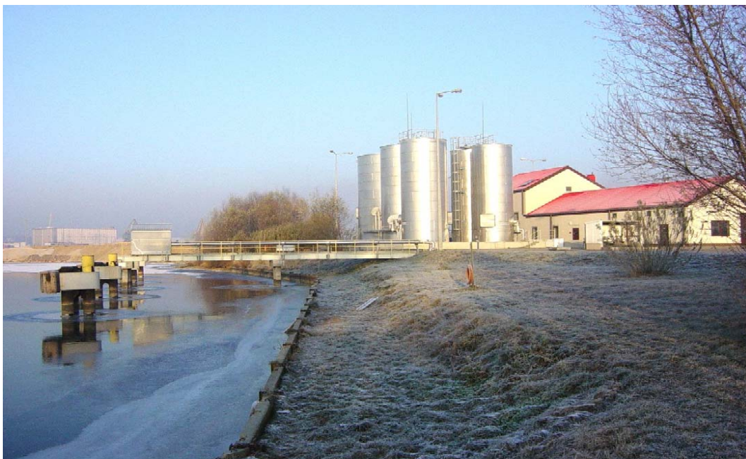
Fot. 4 Dalbowe stanowisko cumownicze na Ostrowiu Grabowskim w Szczecinie - pomost technologiczny z rurociągami i stacją odbiorczą, zbiorniki procesowe oraz budynek z urządzeniami technologicznymi
