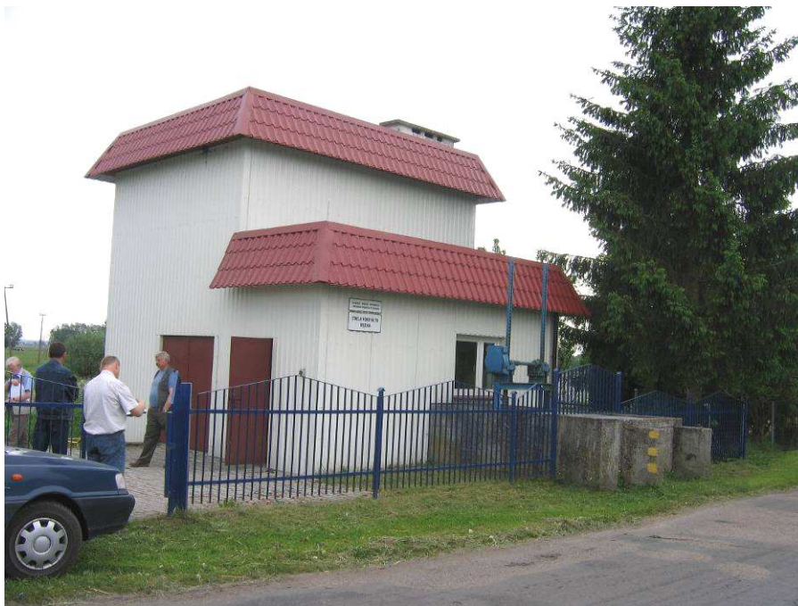
Stacja pomp Nr 70 w miejscowości Wężina (gm. Elbląg), odwadniająca obszar 0,8 tys. ha, odbudowana w 2004 r.
