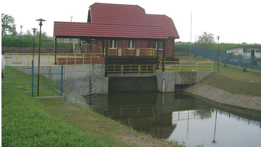
Stacja pomp Nr 36 w miejscowości Nowakowo ( gmina Elbląg), odwadniająca obszar 2,4 tys. ha, odbudowana w 2004 r.
