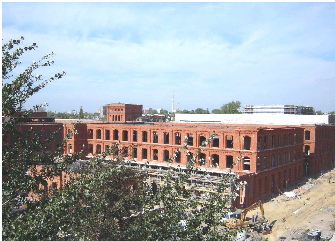
Zdjęcie nr 5 - Budowa kompleksu handlowego „Manufaktura” w Łodzi
