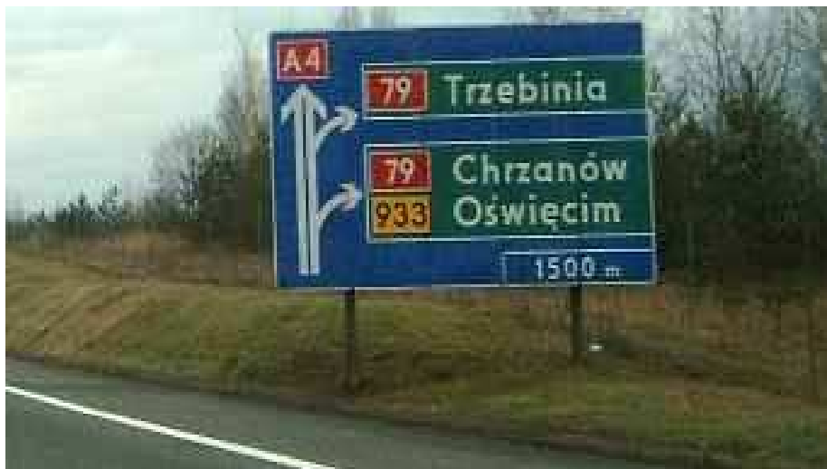
Fot. 21. Tablica E-1a zamontowana przed węzłem Chrzanów II od strony Katowic (stan na czerwiec 2005 r.).
