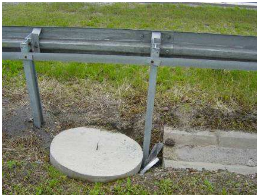
Fot. 15. Posadowienie podpory bariery w studzience – km 358 + 600 – widok wg stanu na czerwiec 2005 r.
