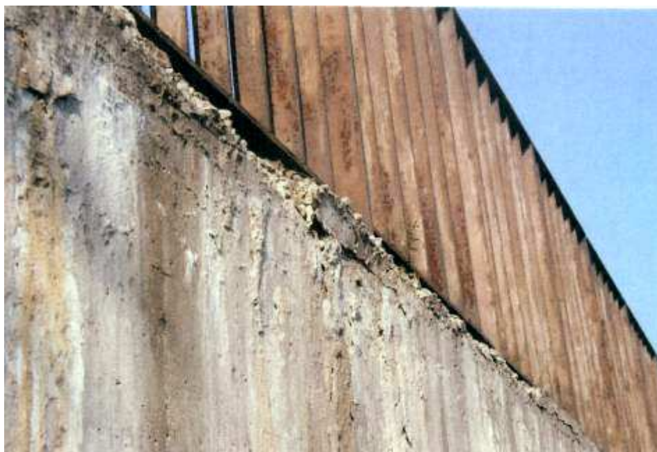
Fot. 10. Obiekt mostowy Nr 56 (zlokalizowany nad autostradą w rejonie miejscowości Balice) – widok wg stanu na wrzesień 2004 r.
