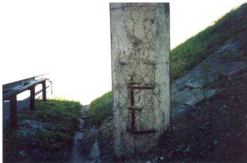
Fot. 1 i 2. Obiekt mostowy Nr 46 (zlokalizowany nad autostradą – w rejonie miejscowości Zalas-Podlesie) – stan na czerwiec 2005 r.
