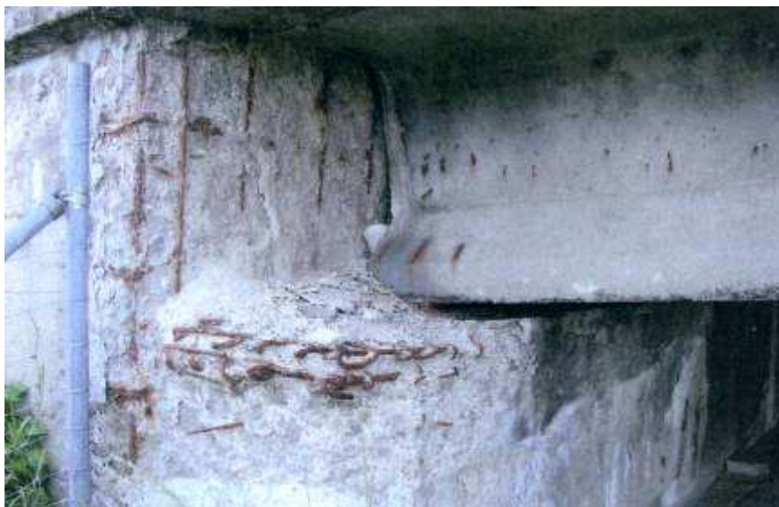
Fot. 9. Obiekt mostowy Nr 41 (zlokalizowany nad autostradą w rejonie miejscowości Rudna) – widok wg stanu na wrzesień 2004 r.
