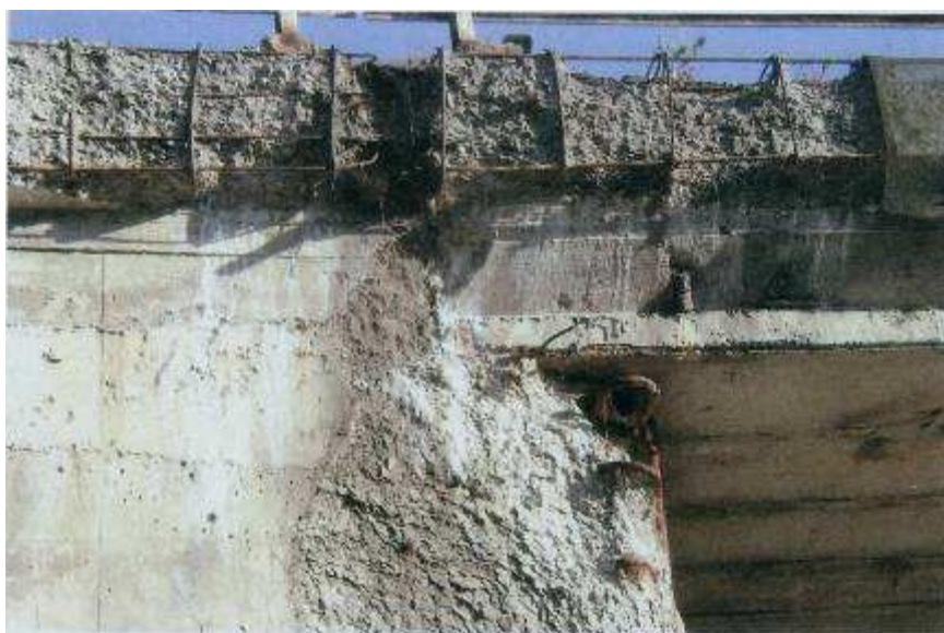
Fot. 3 i 4. Obiekt mostowy Nr 45 (zlokalizowany w ciągu autostrady – w rejonie miejscowości Zalas-Podlesie) – widok wg stanu na czerwiec 2005 r.
