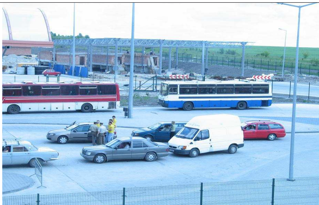
Trzy wagi dynamiczne w budowie – wjazd do RP z Ukrainy
