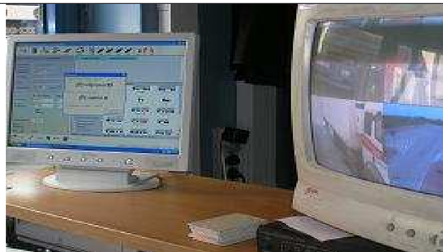
Wyposażenie pomieszczenia wagowego
