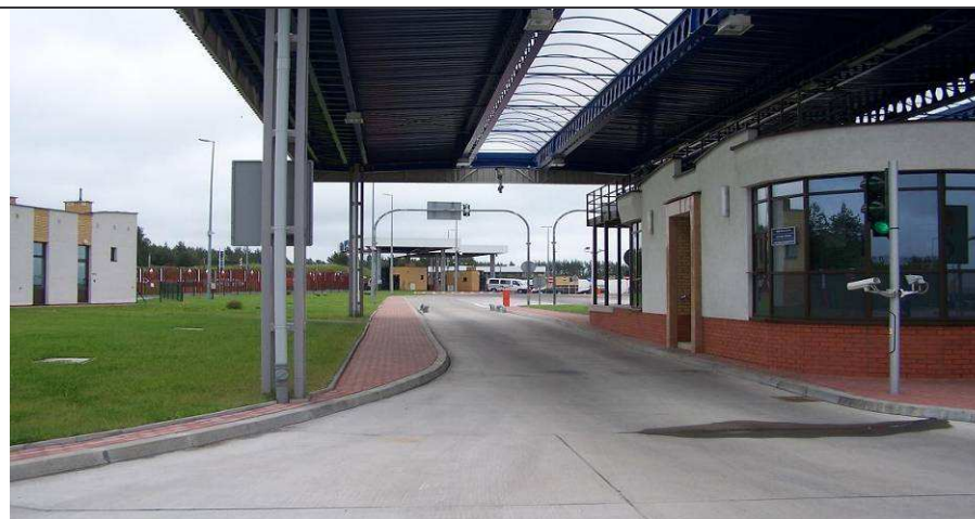
Budynek i zadaszenie wagi dynamicznej na wyjeździe z RP
