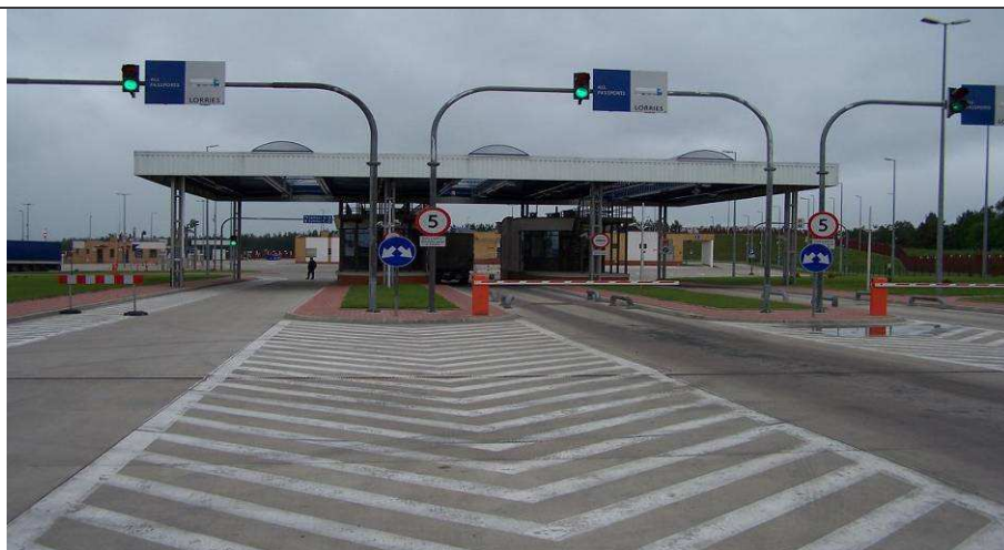
Widok na dwie wagi dynamiczne – wjazd do RP
