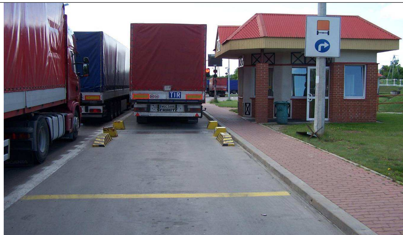
Waga dynamiczna na wyjeździe z RP
