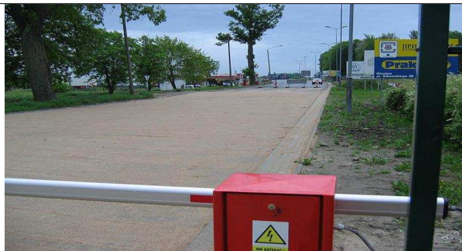
Remontowana nawierzchnia drogi do nieczynnej wagi wyjazdowej z RP
