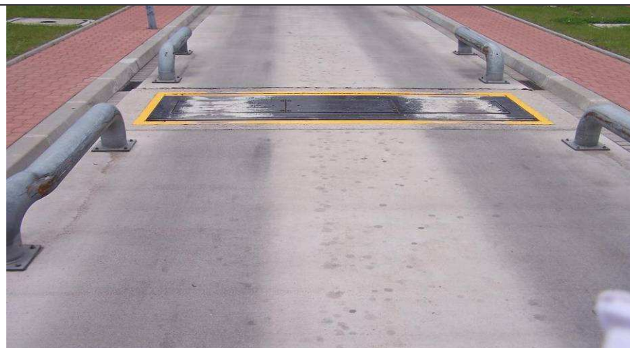
Belka wagi dynamicznej na wjeździe do RP
