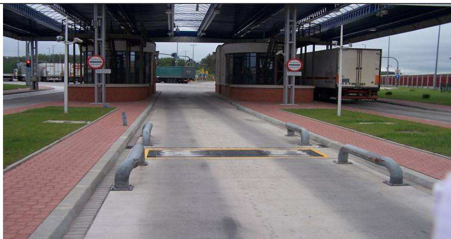
Dwie wagi dynamiczne na wyjeździe z RP
