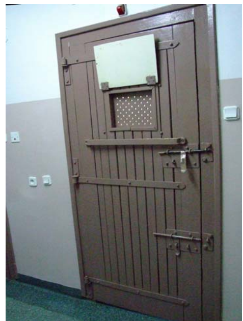
Fot. Typowe dla izb wytrzeźwień, zamykane od zewnątrz, drzwi do pomieszczenia dla osób zatrzymanych (tu MZPiTU w Olsztynie)
