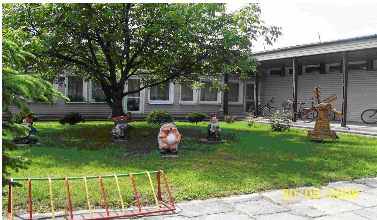
Fot. Nr 5. Obłożenie budynku przedszkola miejskiego w Pruszkowie płytami azbestowo-cementowymi.
