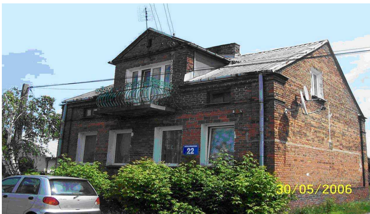
Fot. Nr 4. Pokrycie dachu płytami azbestowo-cementowymi budynku jednorodzinnego w Pruszkowie
