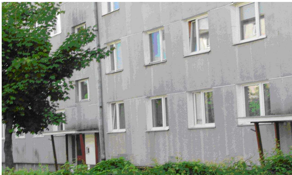
Fot. Nr 1. Obłożenie płytami azbestowo-cementowymi budynku mieszkalnego Spółdzielni Mieszkaniowej w Biłgoraju, ul. Kościuszki
