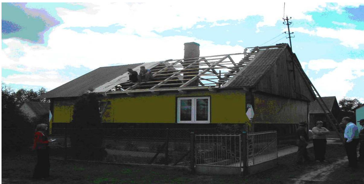
Fot. Nr 11. Demontaż starych płyt azbestowo-cementowych w prywatnym budynku jednorodzinnym we wsi Ostrów, Gmina Dorohusk
