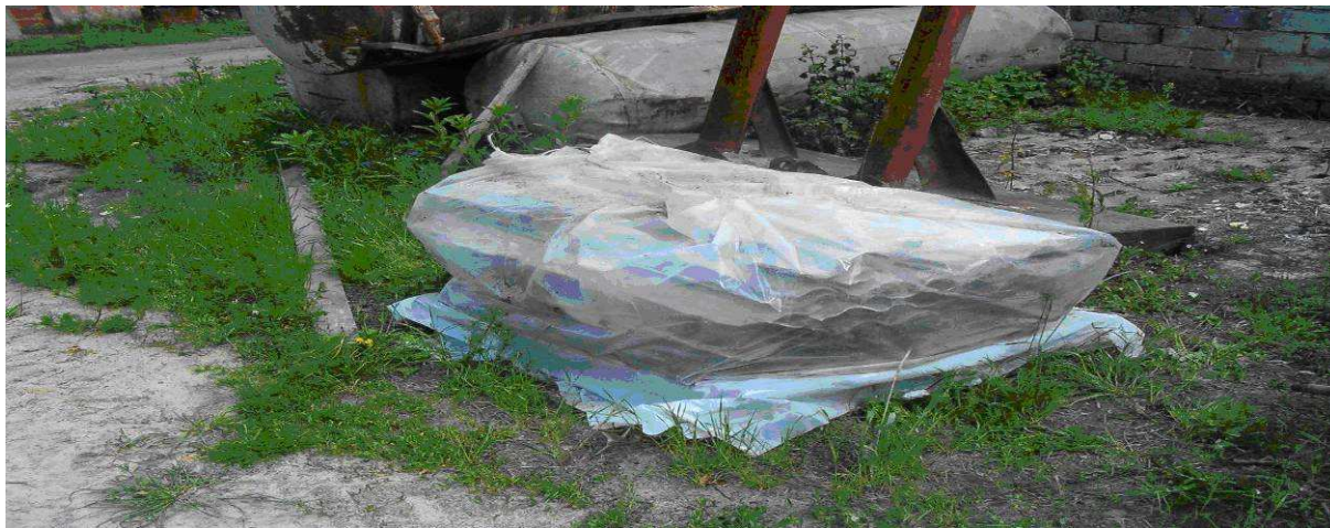
Fot. Nr 10. Zabezpieczone i przygotowane do transportu fragmenty zdemontowanych płyt azbestowo-cementowych na terenie Gminnego Zakładu Obsługi Sp. z o.o. w Dorohusku.
