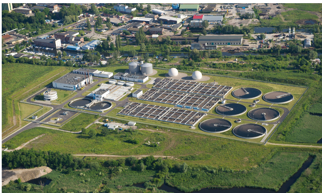
Zdjęcie nr 1 Oczyszczalnia ścieków
