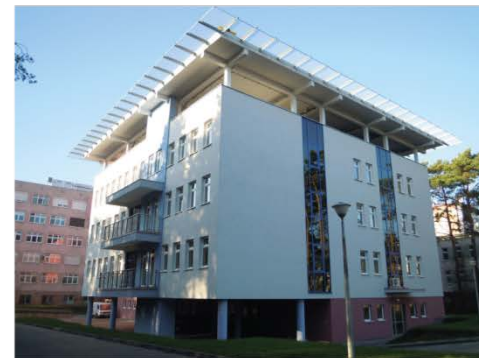
Budynek nr 13 Szpitala Specjalistycznego we Włocławku
