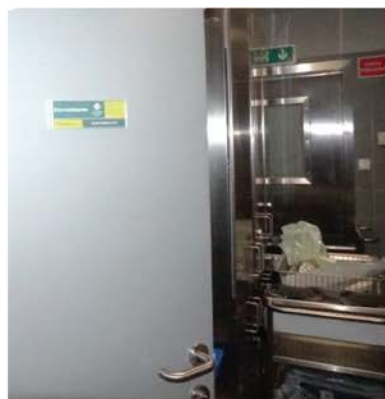
Służa materiałowa w bloku operacyjnym służąca dostarczaniu i krótkotrwałemu przechowywaniu czystych i sterylnych materiałów
