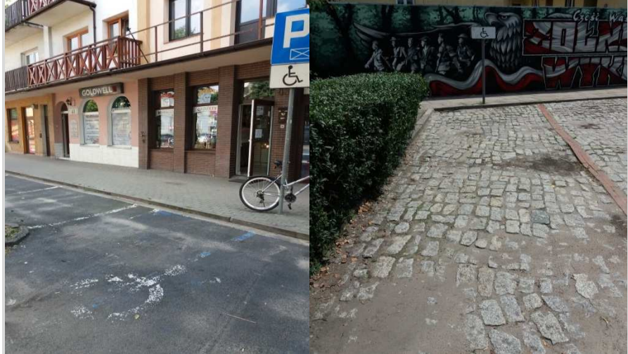
Zdjęcia nr 7-8. Nieprawidłowy sposób wyznaczenia stanowisk postojowych dla osób niepełnosprawnych w Kutnie (ul. Barlickiego oraz ul. Miła)
