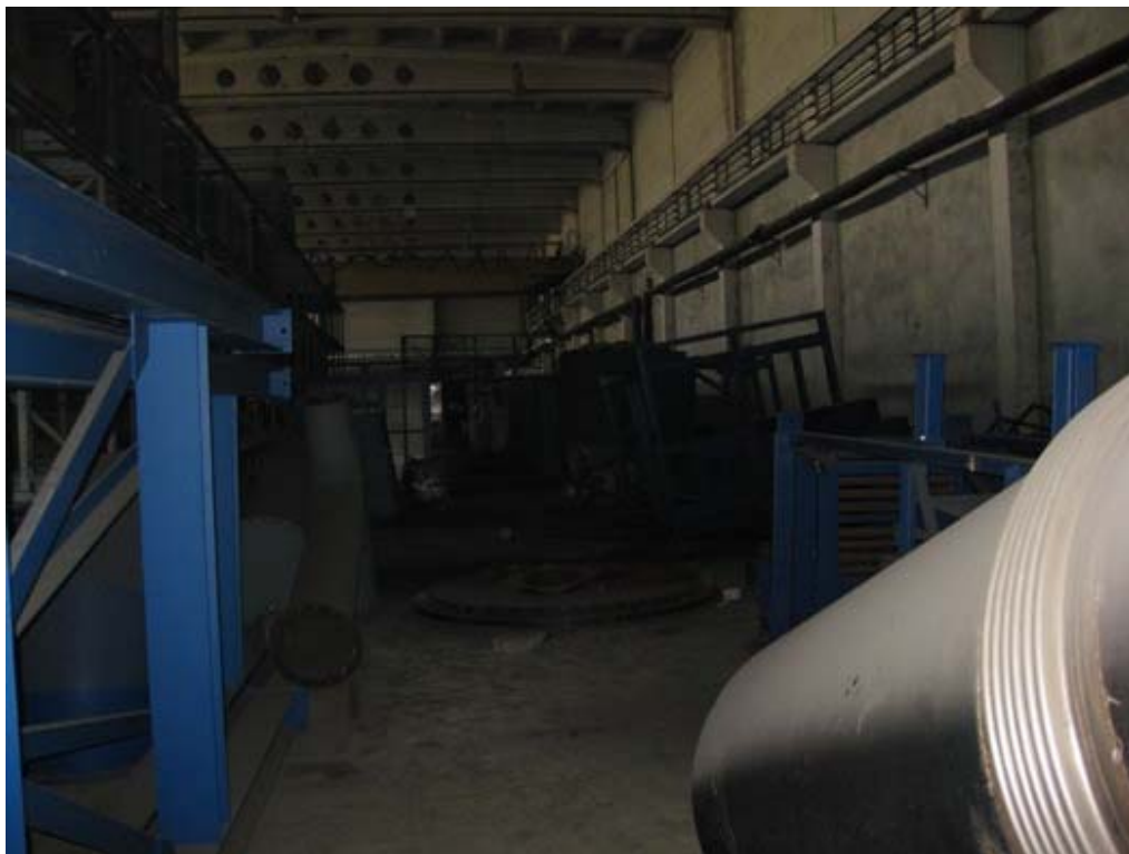
Hala magazynowa – widok ogólny
