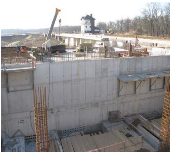
Zdjęcie nr 2. Stan realizacji stopnia wodnego Malczyce w I kw 2011 r.
