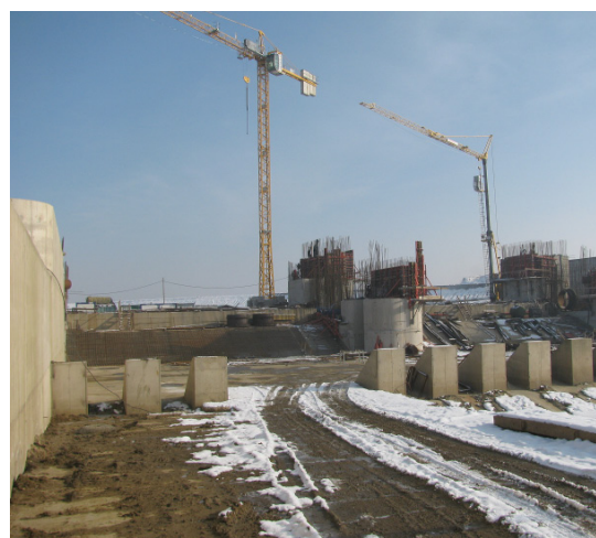
Zdjęcie nr 1. Stan realizacji stopnia wodnego Malczyce w I kw 2011 r.
