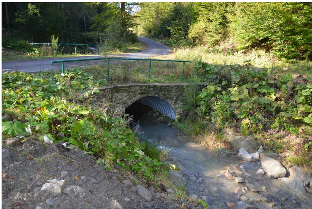
Zdjęcie 2 Przepust wykonany w ramach zabudowy potoku Wielki Suchy przez Nadleśnictwo Ustroń.
